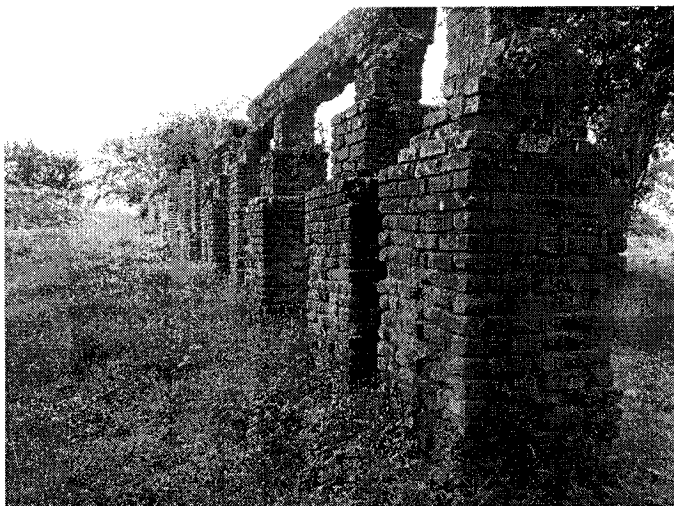
Acueducto Menor (Expulsor de cisco)
